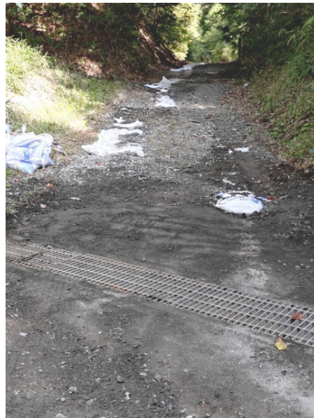
横断溝内の土砂上げ
