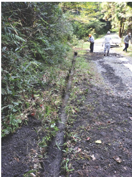
林道脇の側溝土砂上げ
